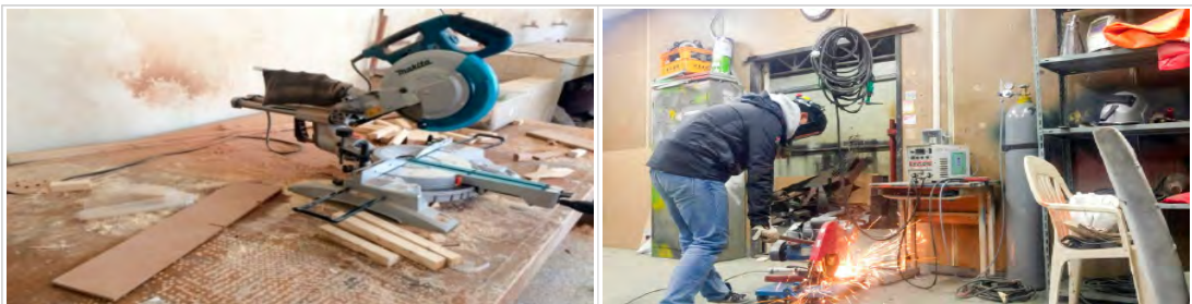
[그림3-2. 비이공계 목공 및 절단 작업]
